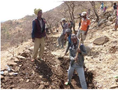
Bauern bei Vorbereitungsarbeiten am Seglem Berg. Es werden Terrassen erstellt, Wassergräben erstellt und Pflanzlöcher gegraben.
