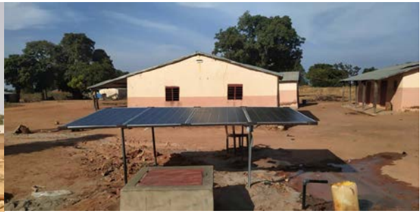
Bohrarbeiten und fertiggestellte Wasserversorgungsanlage beim Gesundheitszentrum Gama
